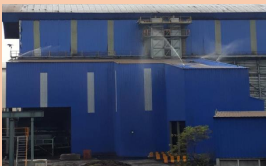
โรงเรือนระบบปิดและติดตั้งสเปรย์ฉีดน้ำแรงดันสูง
