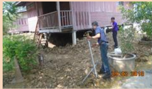
ปรับพื้นที่สถานีอนามัยคลองสะแก ม.1
