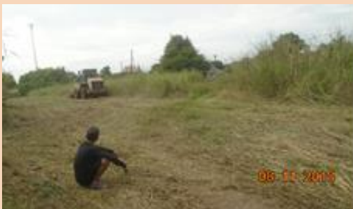
ปรับพื้นที่อาคาร SML คลองสะแก ม.1
